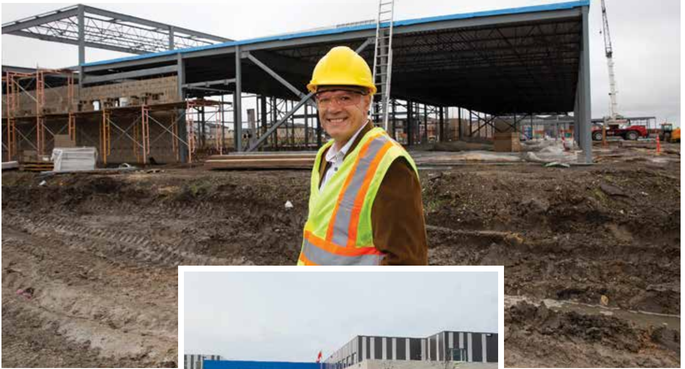
Manuel Silva, directeur de l'École Waterford Springs School, pendant les travaux de construction de l'école.
